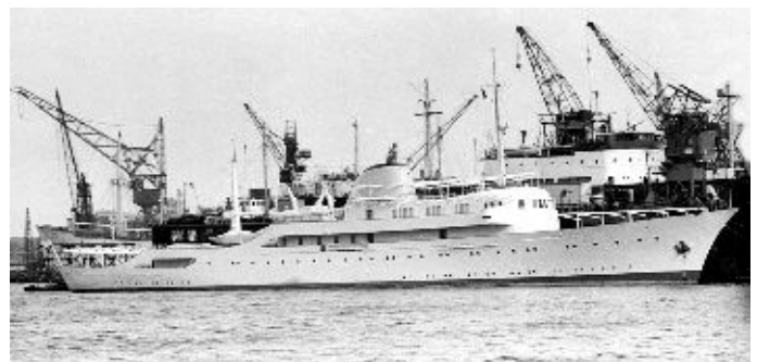
Aus der Fregatte „Stormont“ entstand durch Umbau bei der „Kieler Howaldtswerke AG, Kiel“, von Ende 1952 bis Mitte 1954 die Hochseejacht „Christina“.
