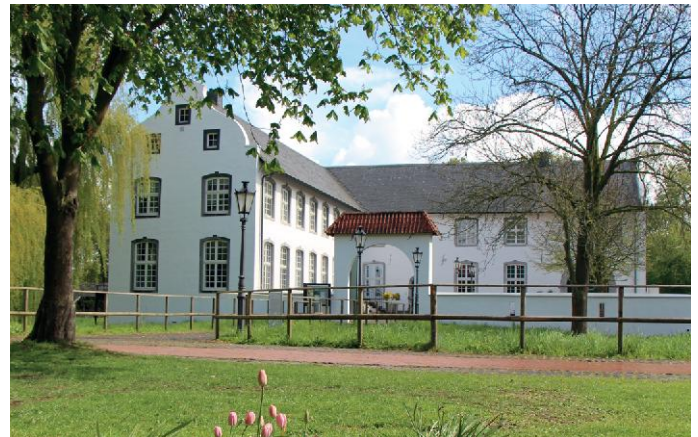
Außenansicht der „Dorenburg“, Kerngebäude des Freilichtmuseums Grefrath. Standort der Wechsel- und Sonderausstellungen. Foto: Kreis Viersen.
