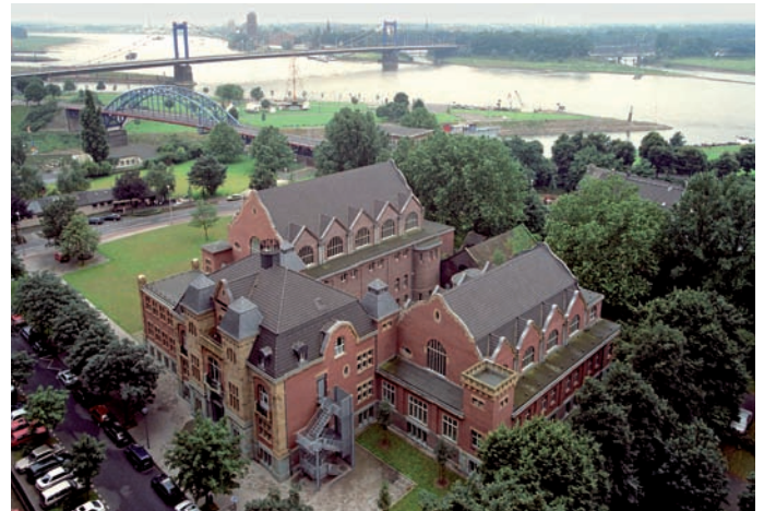
Die idyllische Postkarten-Ansicht des Museums in der ehemaligen Badeanstalt. Den Blick in die Gegenrichtung zeigt die Abb. auf S. 30. Foto: Museum.
